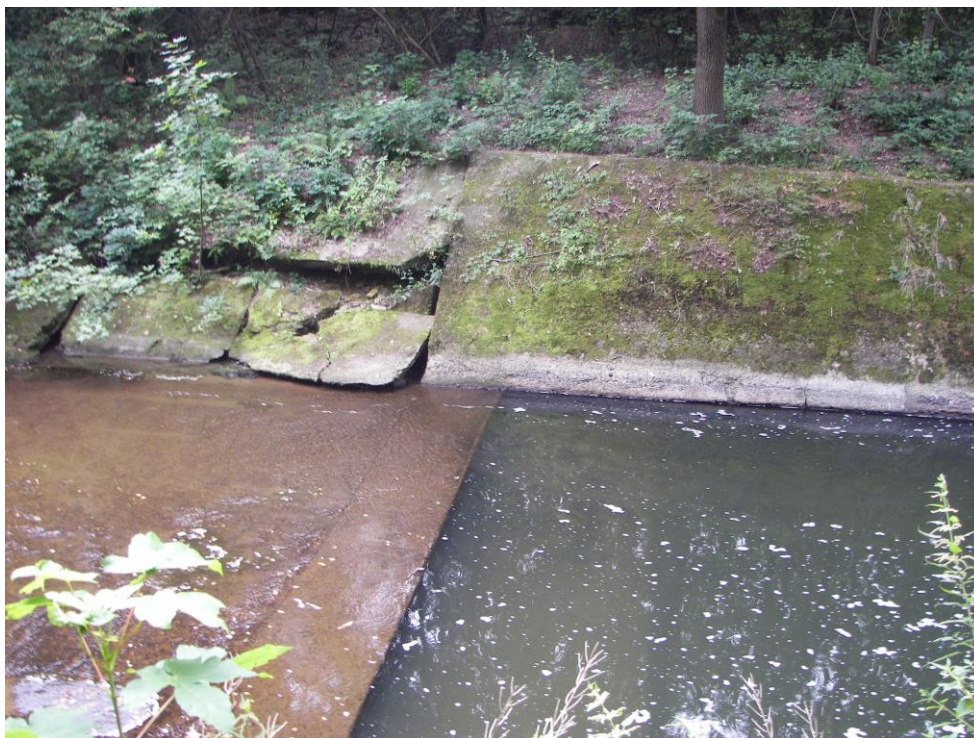
St. č. 13 – pohled na v opevnění pravého břehu v podjezí
