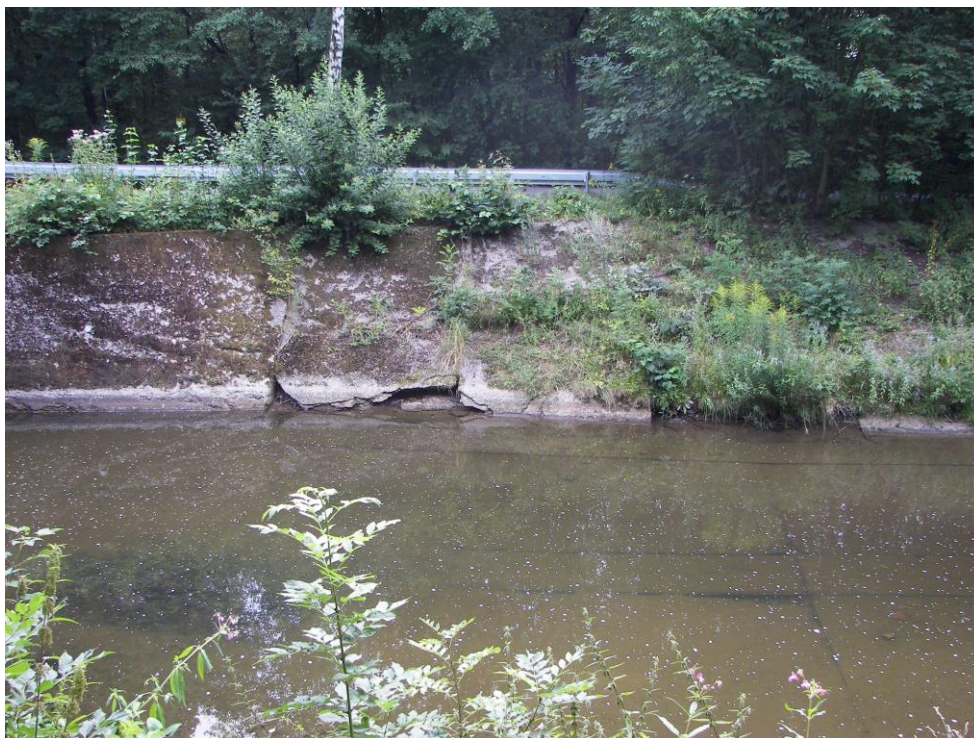
St. č. 16 – pohled na v opevnění pravého břehu v nadjezí
