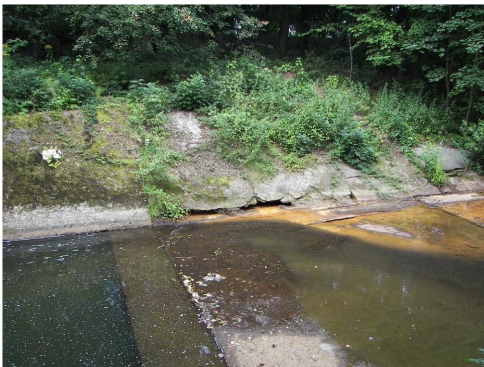
St. č. 16 – pohled na v opevnění levého břehu v podjezí
